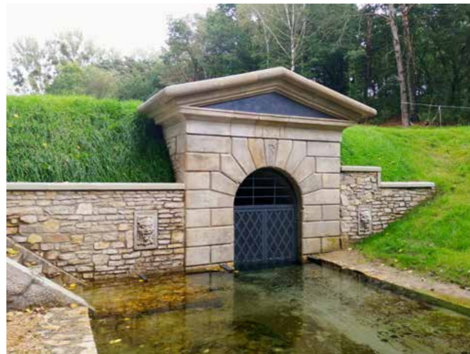
Portal wylotu Sztolni Głębokiej Fryderyk
